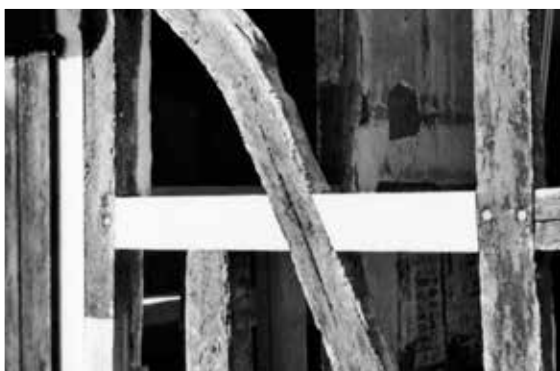
Fynsk Bondehus Restaurering af gavlkonstruktionen og udskiftning af tømmer, begrænset til det højst nødvendigt.
