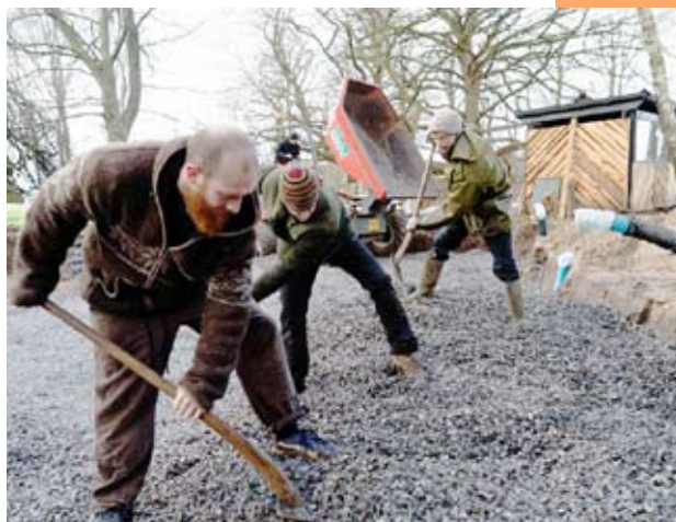
Fundament til halmhuset er bygget af knuste muslingeskaller, der er stampe for hver 30 cm.
