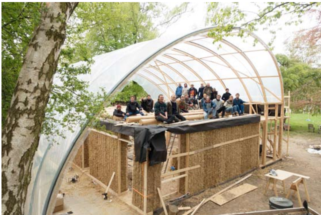
Loftsbjælker af rundtømmer er løftet på plads af hele holdet
