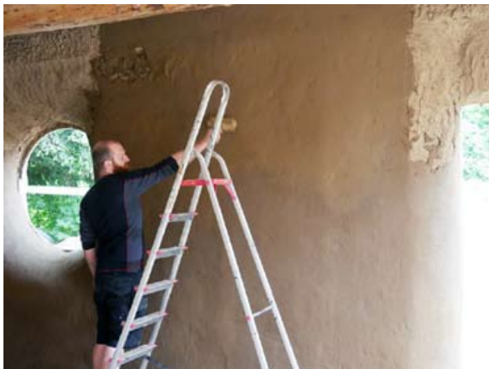
Skillevægge i lersten opmures og ler sprøjtes på halmelementerne, hvorefter de rettes til med lerpuds.
