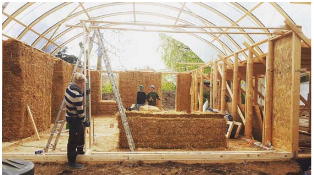
Halmvæggene består af 2,70m høje halelementer der stables på række.
