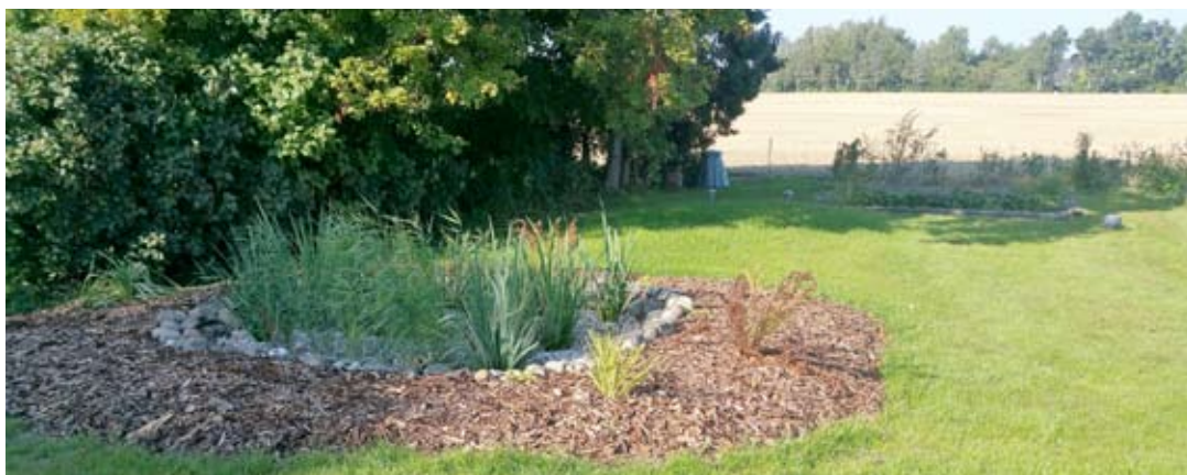
Spildevandsrensning til 1 husstand i Haslev ved Beplantet filteranlæg på 4 m 2 med aktiv beluftning
