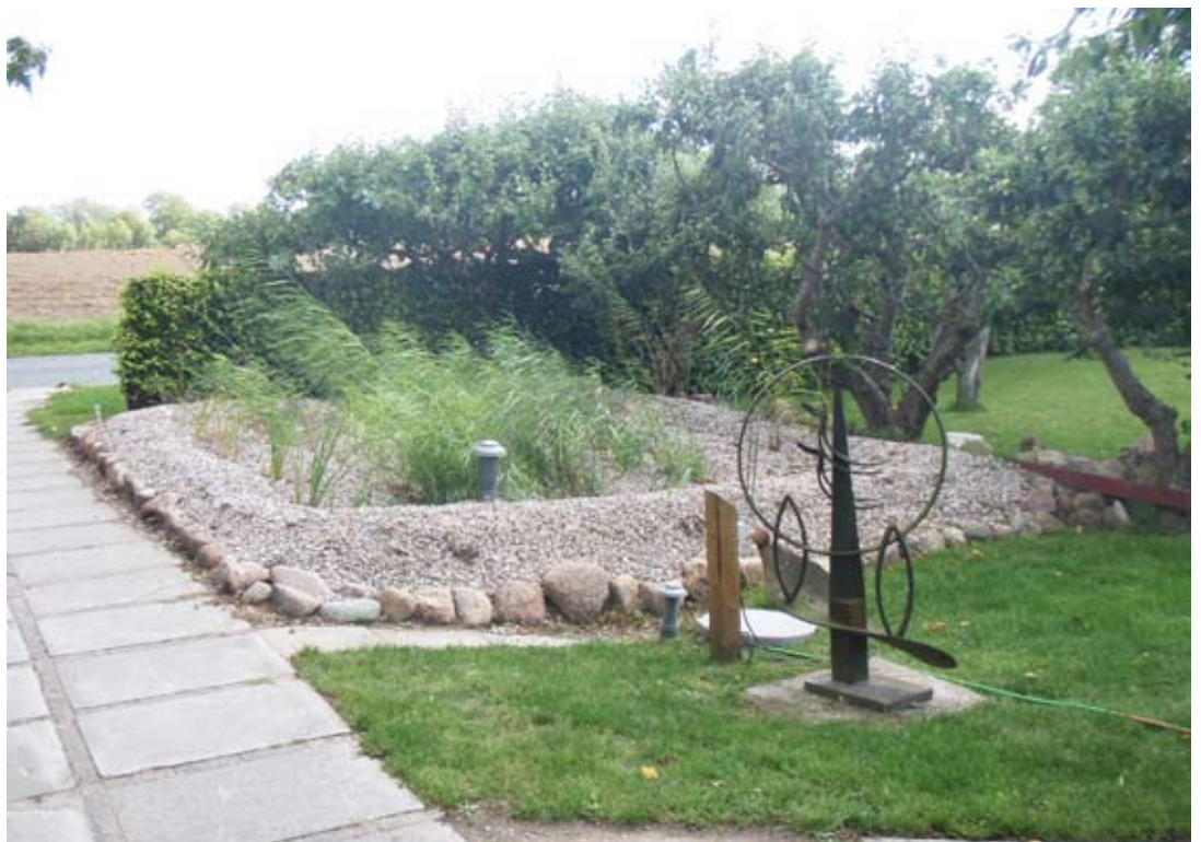
Beplantet filteranlæg på 16 m 2 til 1 husstand på maks 5 personer ved Sandved (mellem Næstved og Slagelse)
