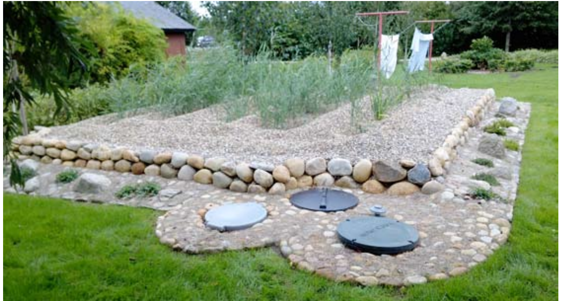
Beplantet filteranlæg på 16 m 2 , inkl. fosforfældningsbrønd til 1 husstand på maks 5 personer ved Struer
