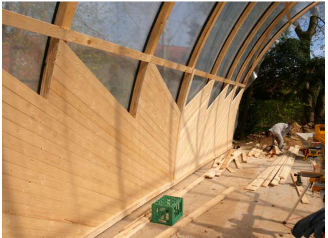
Bagvæggen af huset beklædes med forskalningsbrædder for at beskytte klimaskærmen, og afstive konstruktionen.
