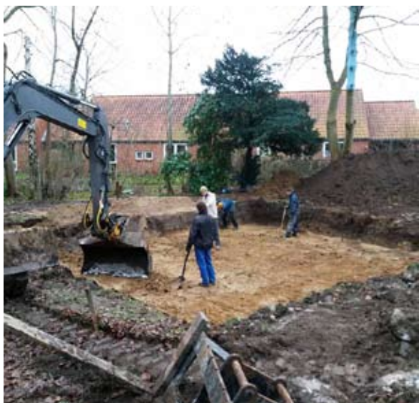
Udgravning til fundament i den lerholdige jord på Nordvestfyn.
