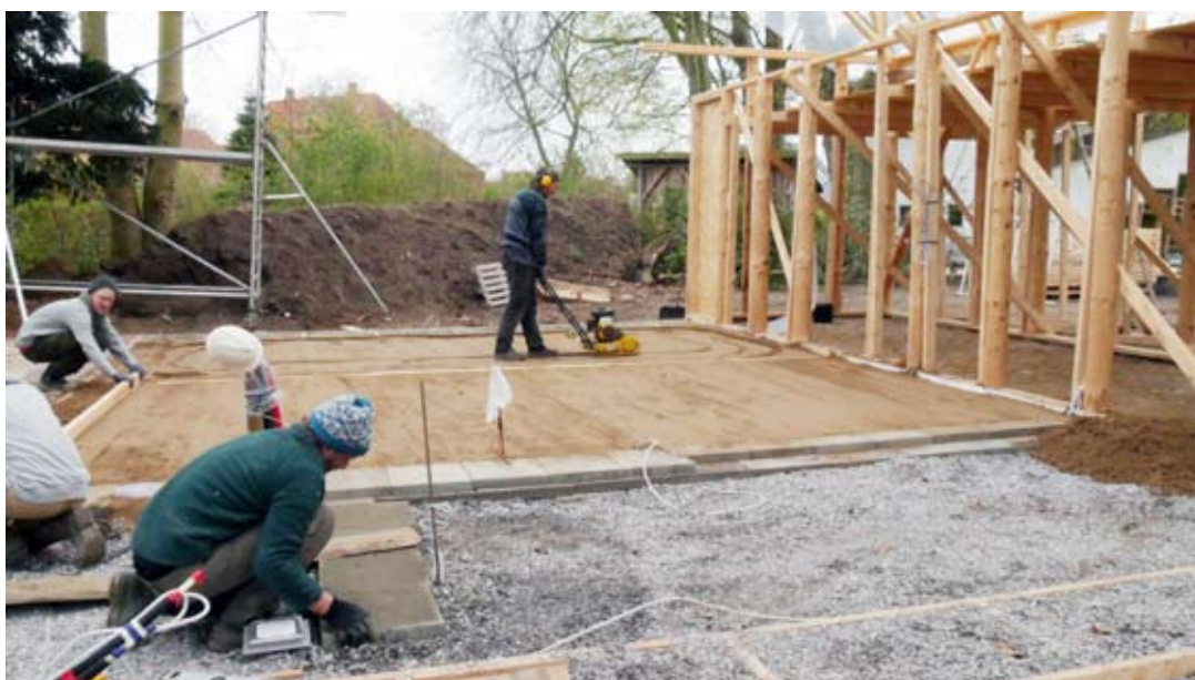
På de knuste muslingeskaller lægges et lergulv, som stemples. Fliser udgør fundament under indervægge af lersten.
