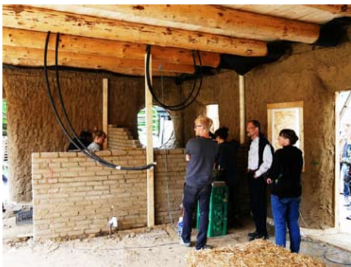
Skillevægge i lersten opmures og ler sprøjtes på halmelementerne, hvorefter de rettes til med lerpuds.
