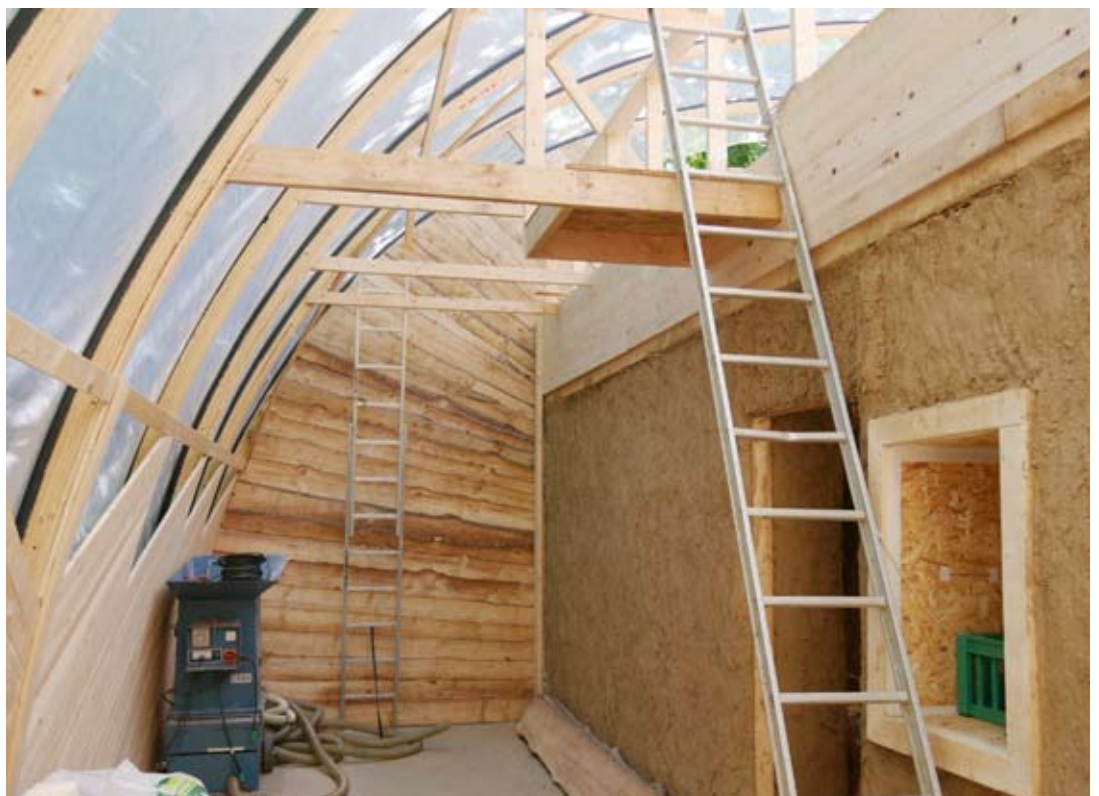
Gavlene lukkes af med kalmarbrædder og bryggerset begynder at tage form.
