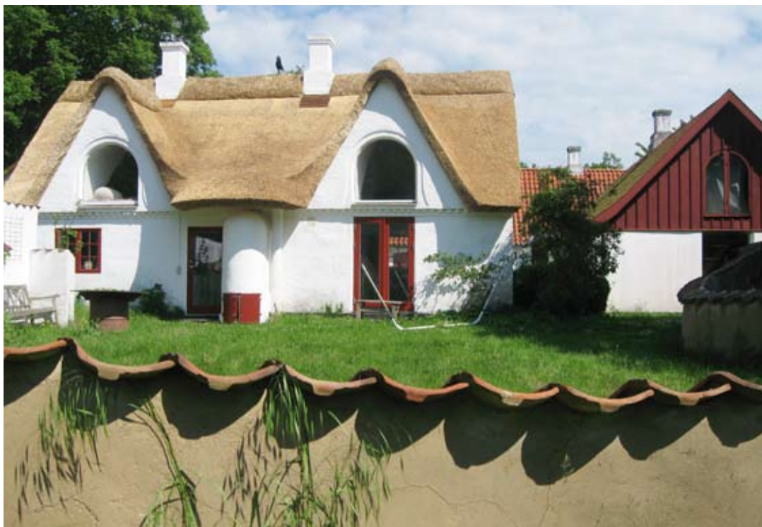
Ombygning af stald, omkranset af lerpudset COB-mur med tagsten som afslutning
