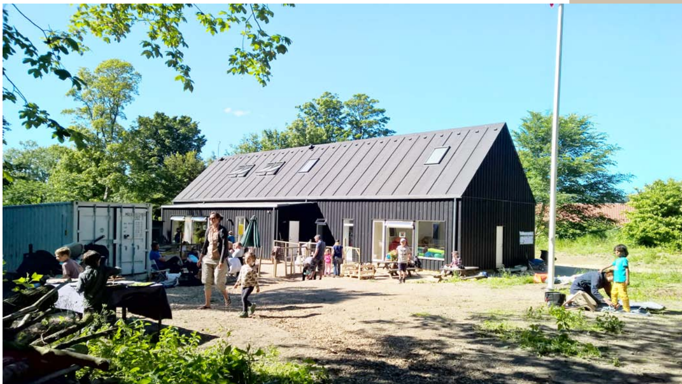
Rønede Frie Skovbørnehus. 300 m 2 børnehave og vuggestue, i halm, ler, udvendig træbeklædning, træuldsisolering i taget. Blyfri vandhaner i køkkenerne! Opført af G&W i 2015.
