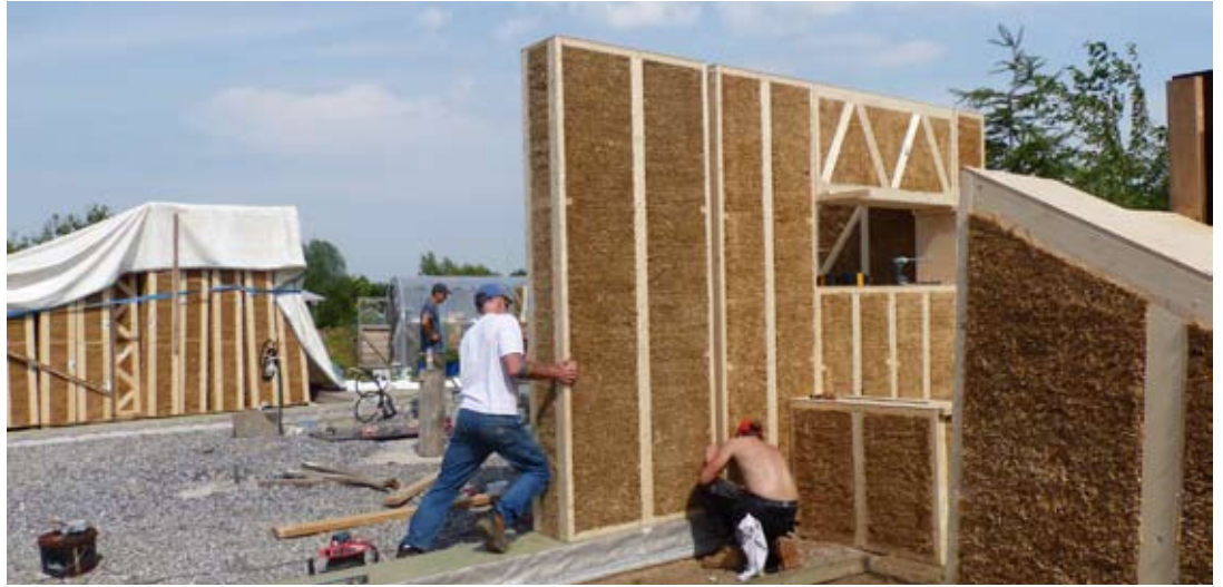
En vinduesoverligger-kassette fastgøres. Litauen.
