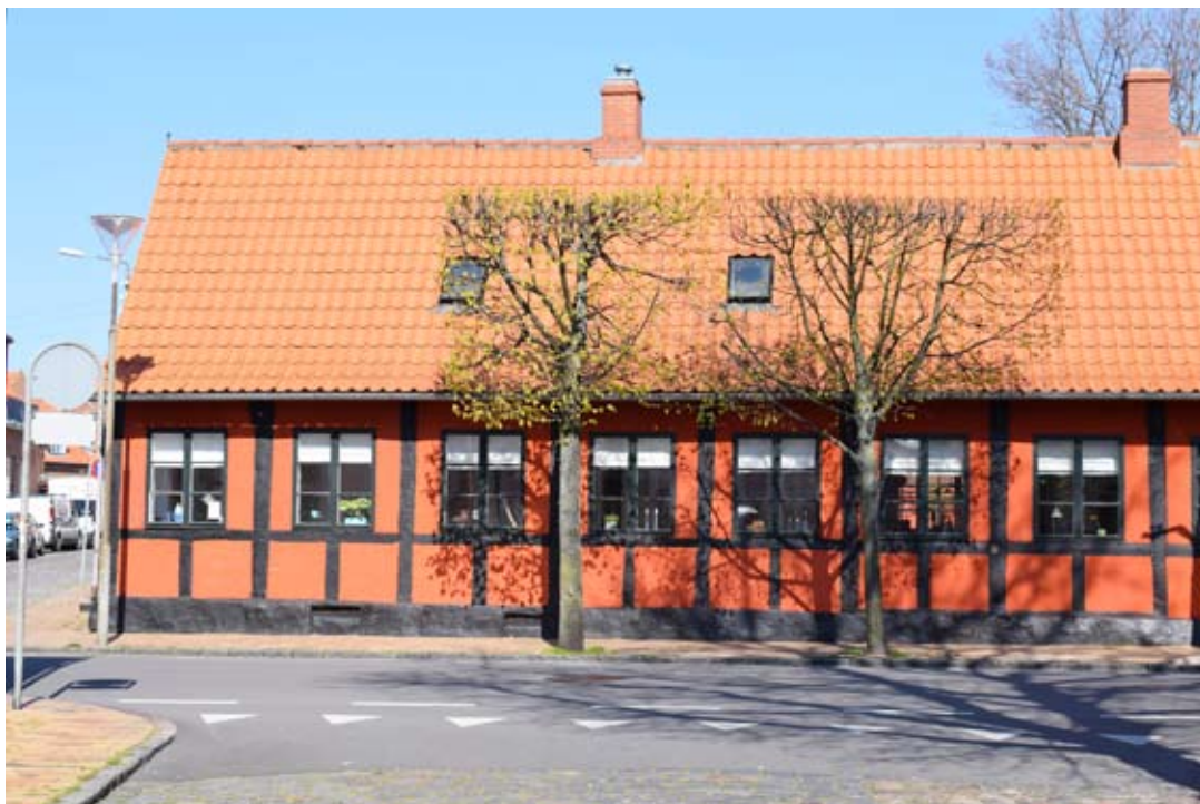
Bindingsværk vedligeholdes så selv vinduerne har originale sprosser (Foto: Inge Vestergaard)
