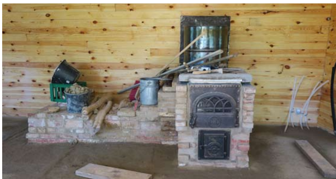
1. etage med flexovn og lergulv i stue og bad. (Foto Britta Edelberg)
