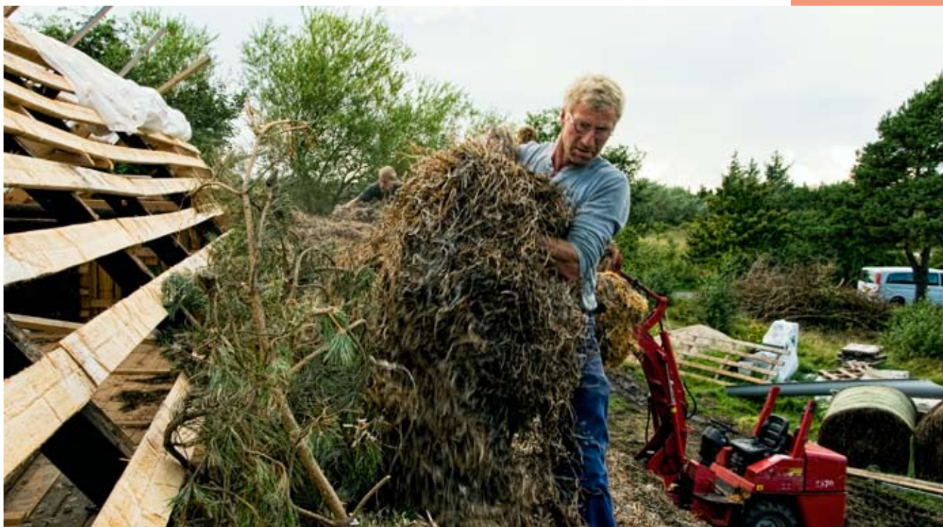
Foto: Læsøs tækkemand, Henning Johansen, er her i færd med at lægge løs tang ud, efter at "vaskerne" forinden er først vredet og dernæst bundet på lægterne. Den tykke "vold" af vaskere er omkring 160 centimeter tyk, og resten af taget består af løs, tørret ålegræs, som i løbet af kort tid danner en hinde og dermed ingen steder blæser. For at forhindre den løse tang i at falde ind på loftet, lægges der fyrregrene ud på lægterne, før ålegræsset kommer på. Taget afsluttes med en rygning af græstørv.
