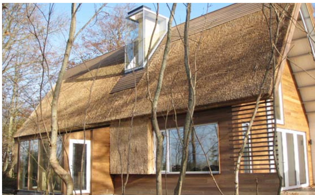
Foto: Det åndbare Hus ved Ringsted. Der er foretaget målinger af fugt og afdampning i huset. De har aldrig vist mere end 13 procents fugt i stråtaget, som dermed på ingen måde er i fare ved høj fugtighed inde fra huset, selvom huset ikke har dampspærre. Inden længe flytter en familie ind i huset. Målingerne vil vise, hvad deres fordampning medfører. Alt tyder på, at huset evner at borttransportere fugten uden at skade byggematerialerne.
