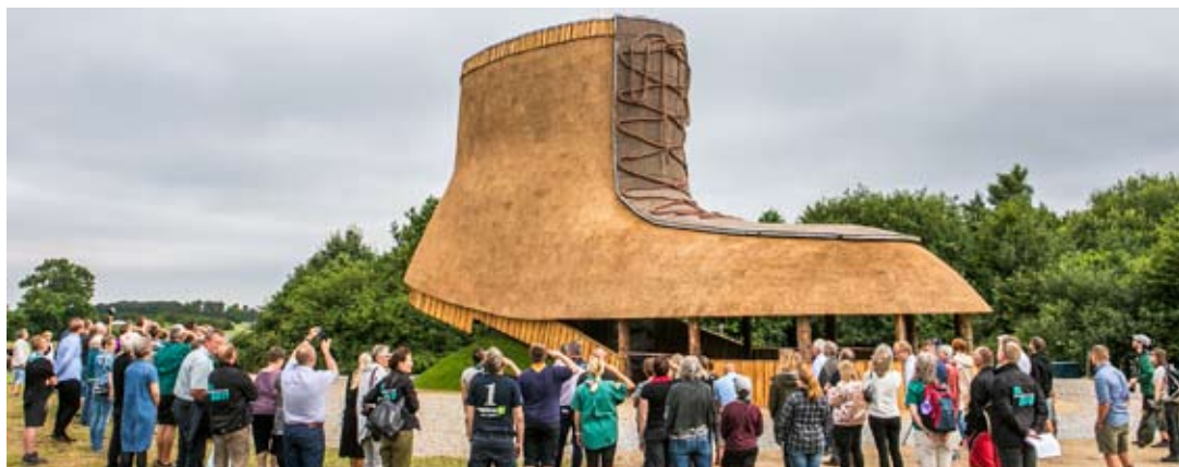
Foto: Det åndbare Hus ved Ringsted. Der er foretaget målinger af fugt og afdampning i huset. De har aldrig vist mere end 13 procents fugt i stråtaget, som dermed på ingen måde er i fare ved høj fugtighed inde fra huset, selvom huset ikke har dampspærre. Inden længe flytter en familie ind i huset. Målingerne vil vise, hvad deres fordampning medfører. Alt tyder på, at huset evner at borttransportere fugten uden at skade byggematerialerne.
