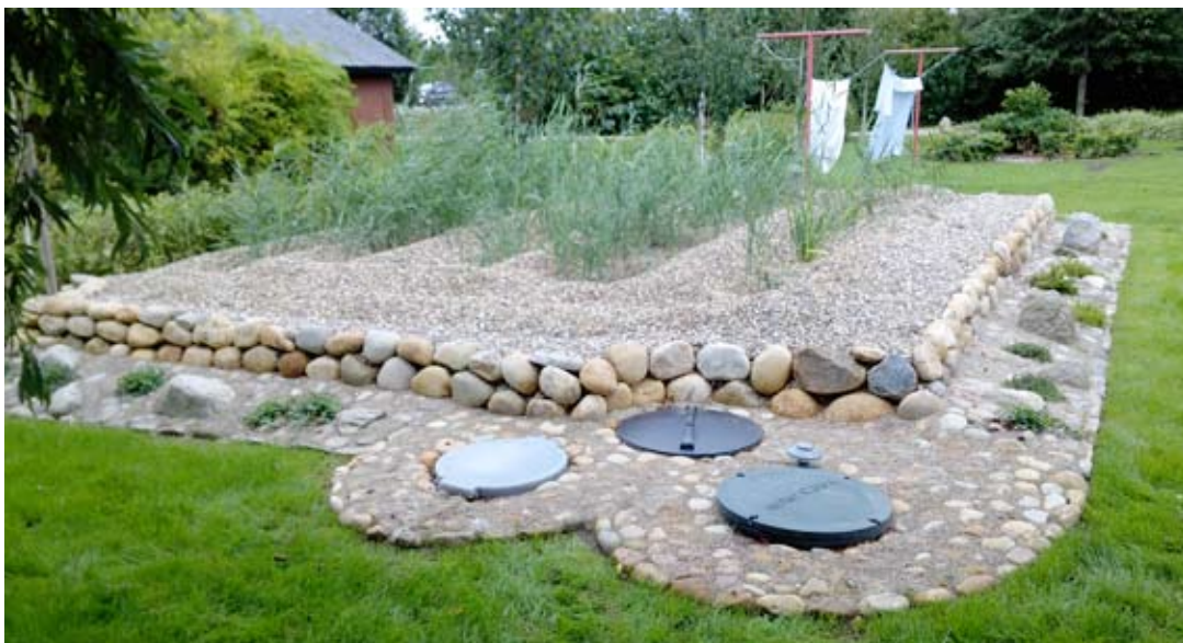
Beplantet filteranlæg på 16 m 2 , inkl. fosforfælningsbrønd til 1 husstand på maks 5 personer ved Struer
