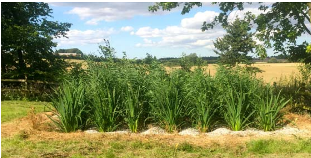
Spildevandsrensning til 10 husstande i Havdrup med beplantet filteranlæg på 25 m 2 med aktiv beluftning
