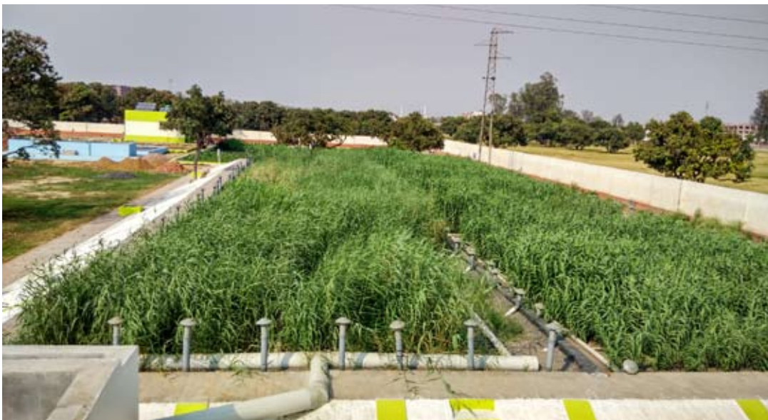
Kombination af 2 beplantet filteranlæg og 2 rodzoneanlæg på i alt 2000 m 2 til 1000 personer til en universitet i Indien. Alt det rensede spildevand genbruges til landbrug og toiletskyl.
