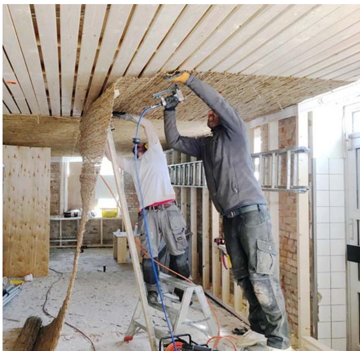
Montering af rørvæv i loftet kræver utroligt mange klammer.
