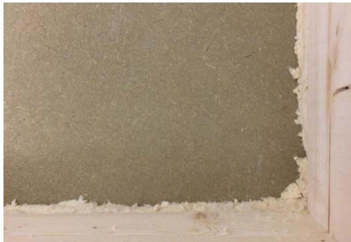
På toiletterne i stueplan bliver den rå lervæg ladet synlig. På billedet kan man stadig ane træfiberisoleringen.
