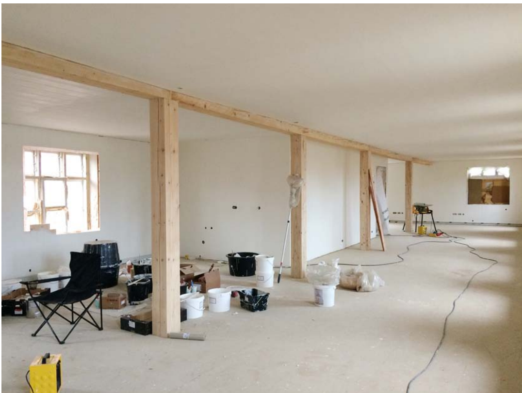
Lervægge og -lofter har fået 3 lag kvark/ler/kalk maling.
