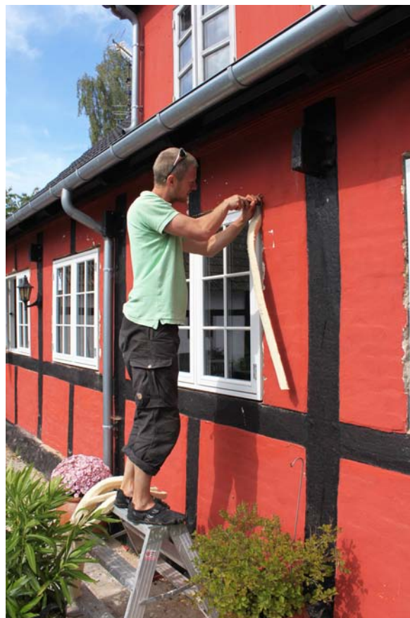
Danskproducerede trævinduer monteres med træfiberisolering og tjæret værk.
