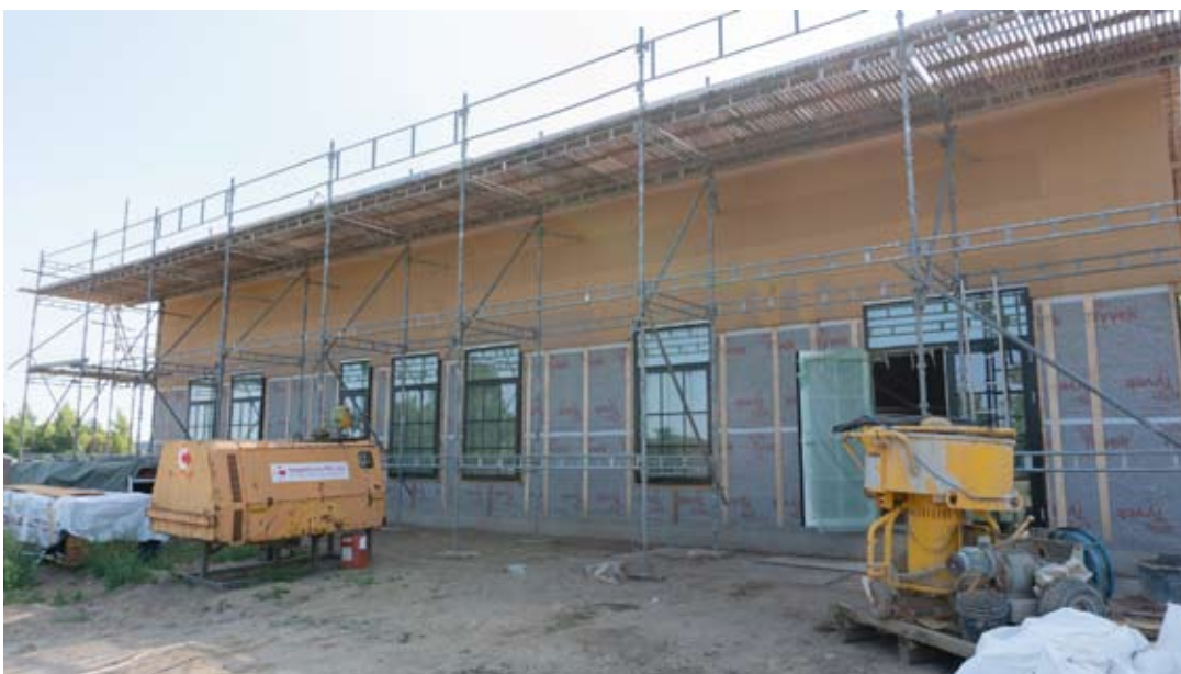
Maskineri til på-sprøjtning af lerpuds indvendigt står klar. Vindspærren er synlig nederst, Steico-pladerne øverst. Døre og vinduer fra Ventilationsvinduet.
