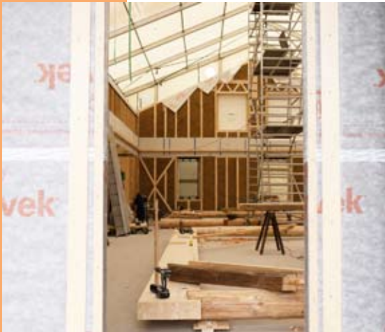
EcoCocon modulerne med vindspærre monteret på ydersiden
