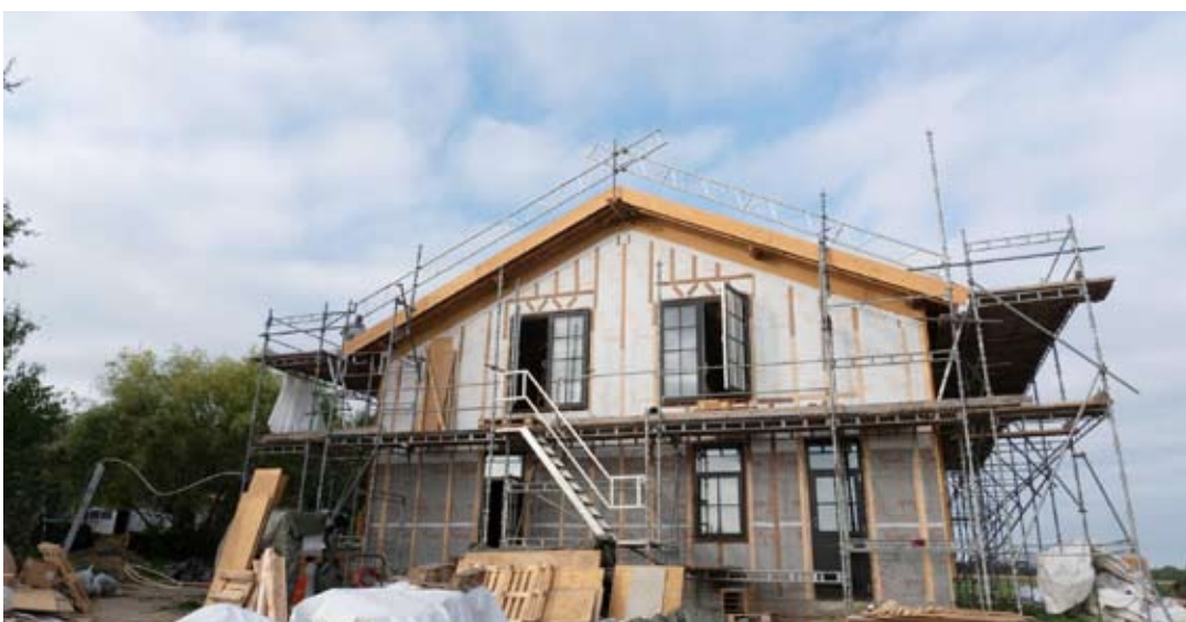
Maskineri til på-sprøjtning af lerpuds indvendigt står klar. Vindspærren er synlig nederst, Steico-pladerne øverst. Døre og vinduer fra Ventilationsvinduet.
