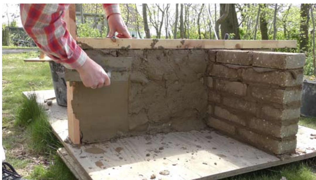
De små film lavet af Ida Nielsen fra Egen Vinding og Datter viser helt konkrete teknikker som her: lerpuds på lerstensvæg.
