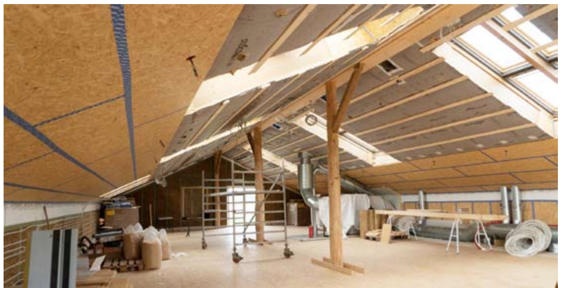
Tagkonstruktion som indeholder følgende lag: fibergips (Fermacell), I-bjælker (Steico SJ60 x 360mm), træuld (Steico Zell), fast undertag (Steico Universal 52mm), klemme til ventilation, ruhøvede tagbrædder, tagfolie, løs ålegræs.
