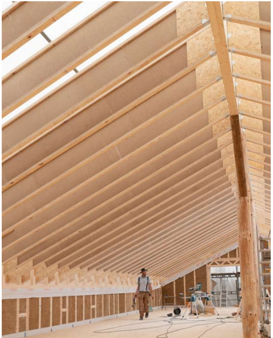
Tagkonstruktion som indeholder følgende lag: fibergips (Fermacell), I-bjælker (Steico SJ60 x 360mm), træuld (Steico Zell), fast undertag (Steico Universal 52mm), klemme til ventilation, ruhøvede tagbrædder, tagfolie, løs ålegræs.
