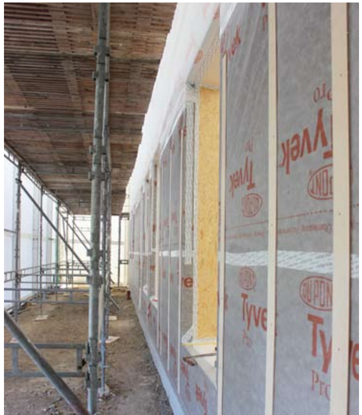
EcoCocon modulerne med vindspærre monteret på ydersiden
