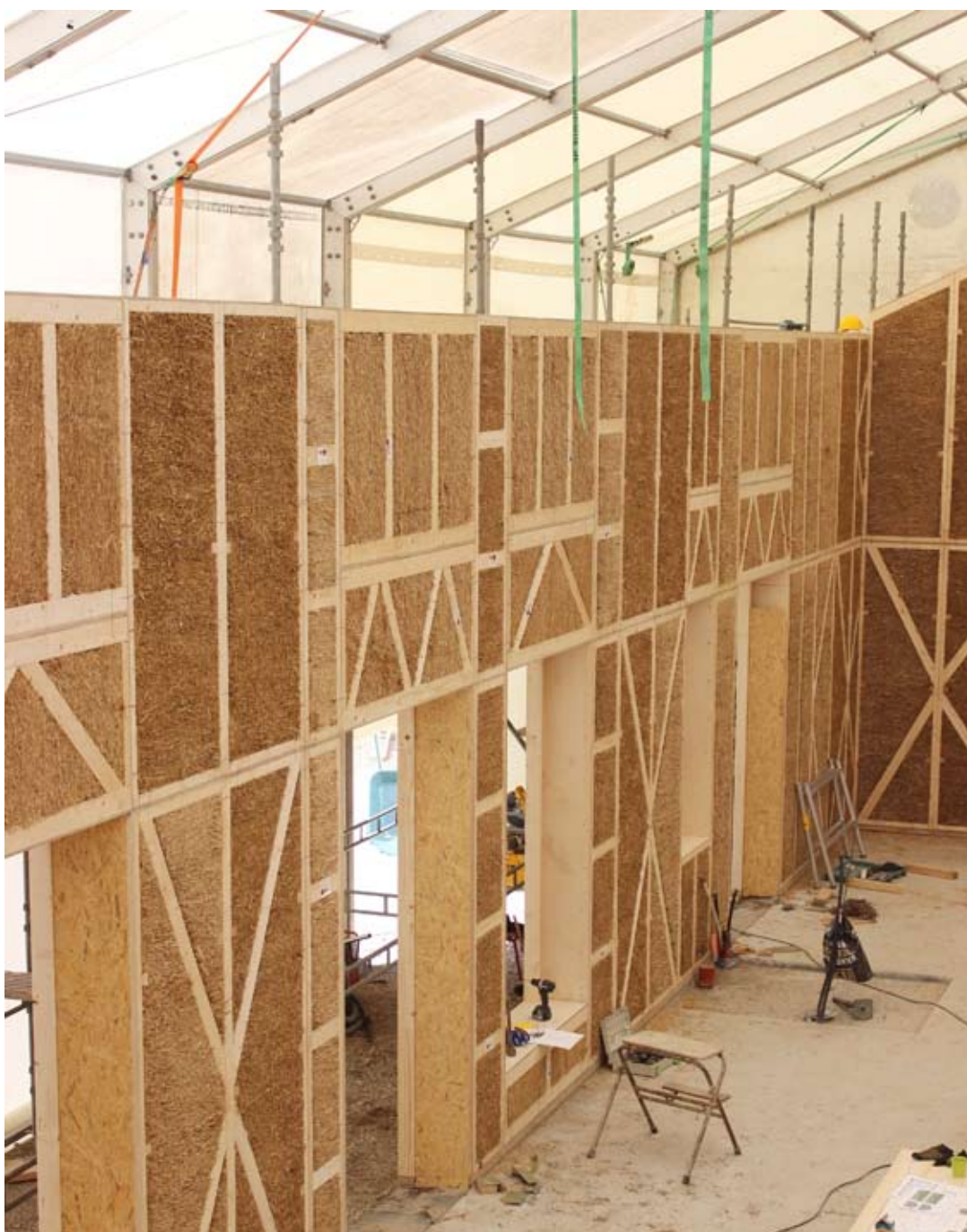
Teltet yder beskyttelse under hele byggeriet. EcoCocon modulerne blev rejst på 5 dage af et sjak på 6 mand, hvoraf halvdelen ikke tidligere havde bygget med EcoCocon.
