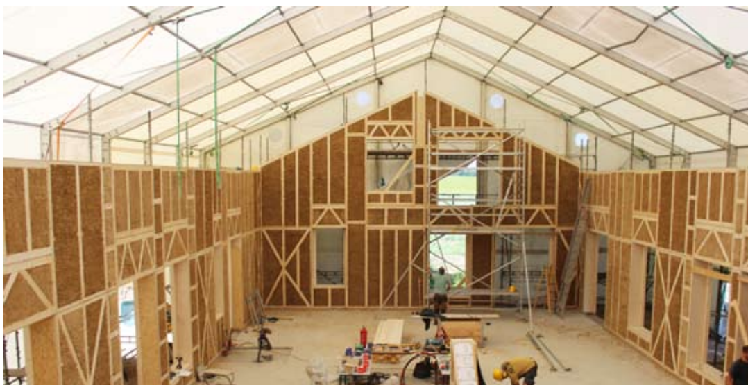
Teltet yder beskyttelse under hele byggeriet. EcoCocon modulerne blev rejst på 5 dage af et sjak på 6 mand, hvoraf halvdelen ikke tidligere havde bygget med EcoCocon.
