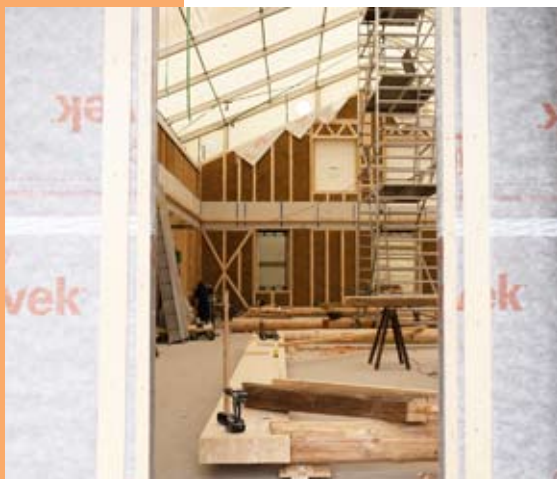
EcoCocon modulerne med vindspærre monteret på ydersiden
