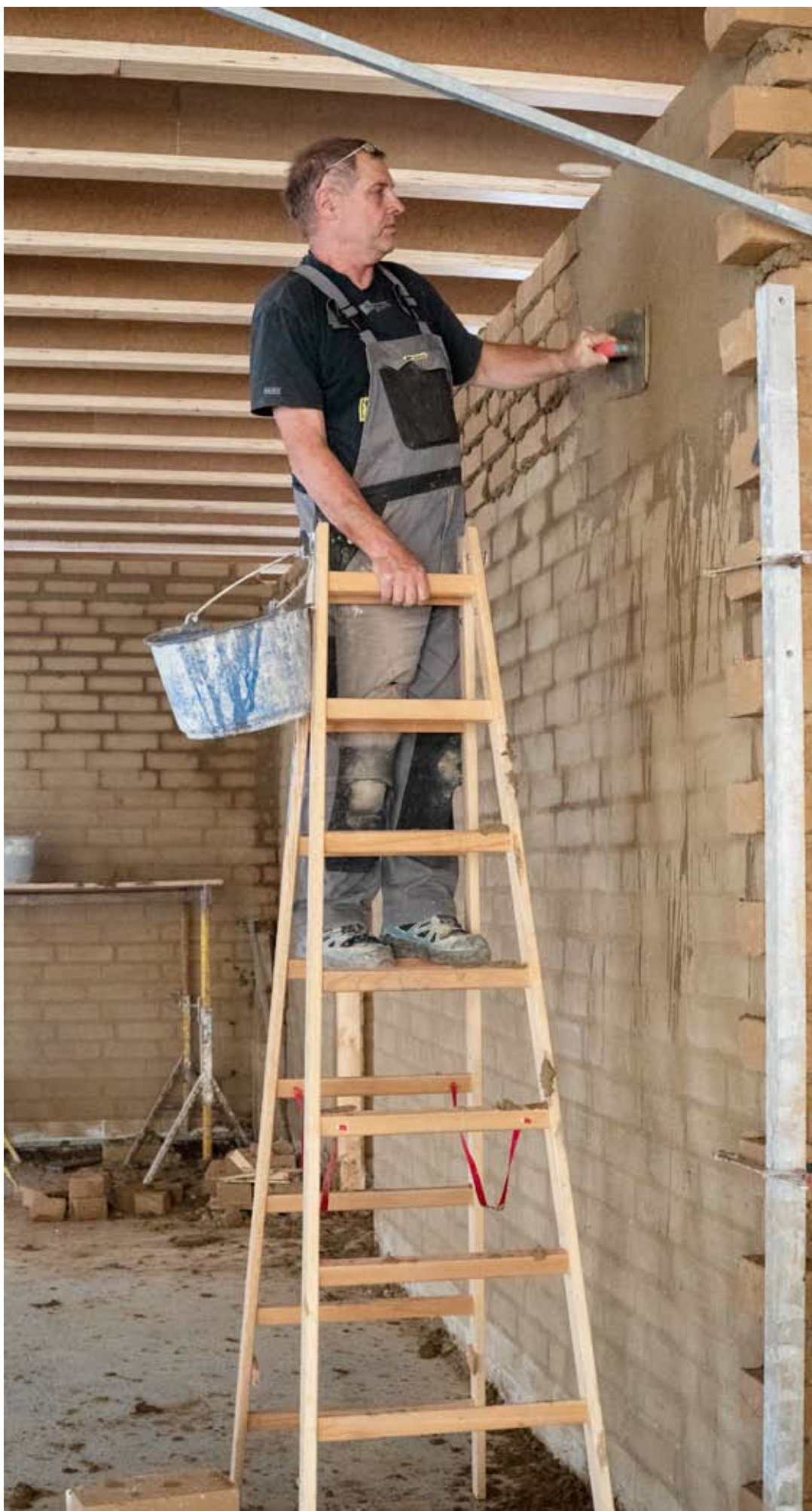
Indervæggene bygges af OSKAMs CEB-sten (pressede ubrændte lersten)
