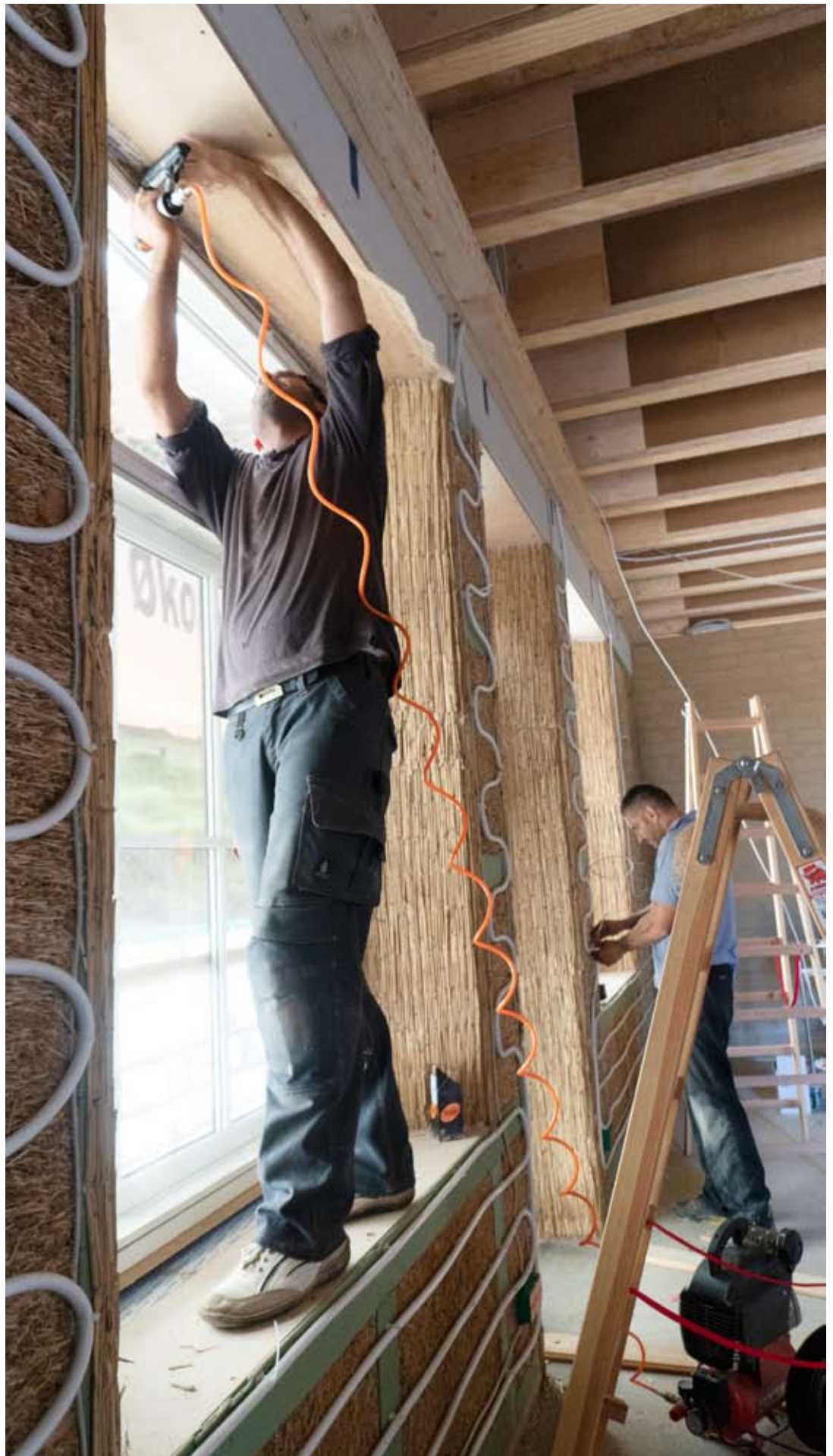
Der bruges varmevægge, suppleret med gulvarme.
