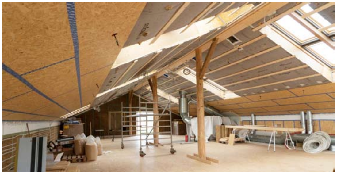
Tagkonstruktion som indeholder følgende lag: fibergips (Fermacell), I-bjælker (Steico SJ60 x 360mm), træuld (Steico Zell), fast undertag (Steico Universal 52mm), klemliste til ventilation, ruhøvede tagbrædder, tagfolie, løs ålegræs.
