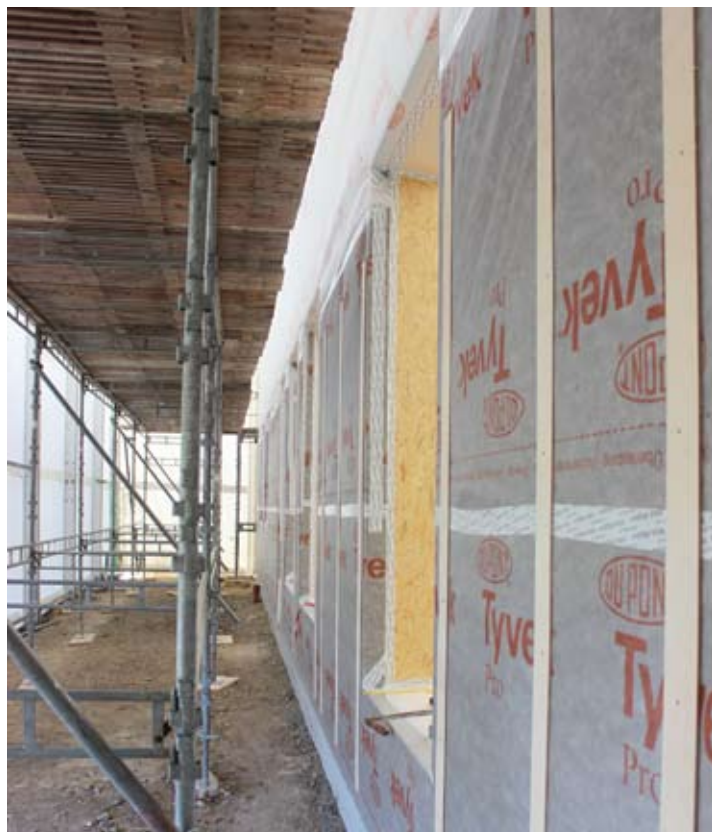
EcoCocon modulerne med vindspærre monteret på ydersiden
