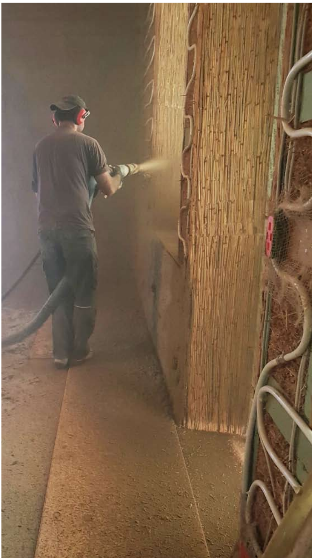
Beklædning indvendig er lerpuds udført af "Ler for Livet" ved murer Muhammad Tahir.
