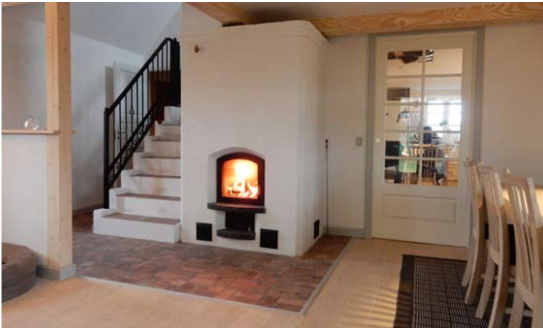
Foto: En masseovn udmærker sig ved at den kan holde husets temperatur jævn gennem hele dagen. Den danner varme af lokalt tørt træ, akkumulerer varmen i stenmassen og har ingen ledningstab.
