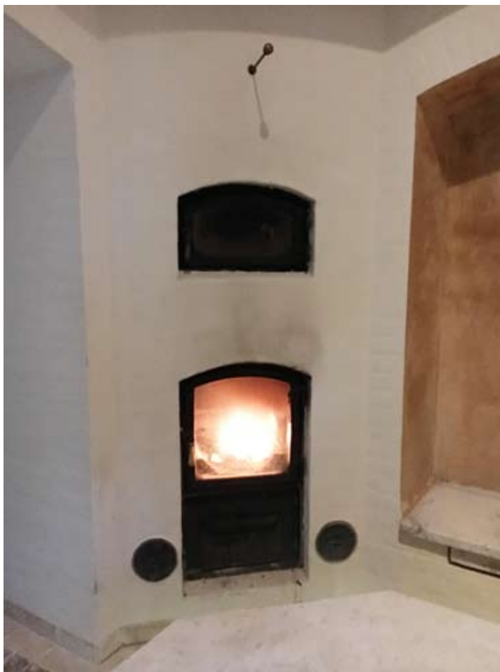
Masseovn i Hammam - rummet er del af Sofiebadets energitilførsel.
