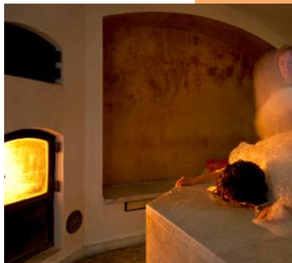
Masseovn i Hammam - rummet er del af Sofiebadets energitilførsel.
