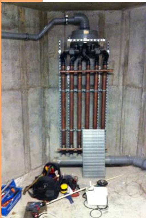
Foto af Hei-Tech.nl mens det bliver installeret
