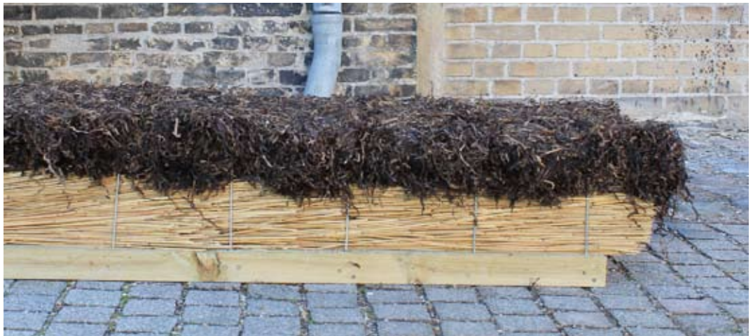
Fotos: Et afgangsprojekt fra arkitektskolen i København beskriver en helt ny type tag, nemlig et kombineret strå- og tangtag. Dvs. at der først tækkes med tagrør eller tækkemiscanthus (en speciel type elefantgræs) og oven på stråtaget lægges et lag ålegræs. Inspirationen til det er hentet fra Kina. Den ene af de to afgangsstuderende, Lise Hornehøj Garval, er på billedet herunder i gang med at lave mockup'en med det kombinerede strå- og ålegræstag. (fotos: Nanna Hedensted Lundorf)
