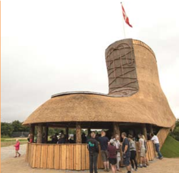
Fotos: Den tækkede stovle har måtter af ålegræs, lagt på tagpap. Et 12m høj Udkigstårn for oven og "frokoststue" for neden. (Spejdernes landslejr ved Sønderborg 2017)
