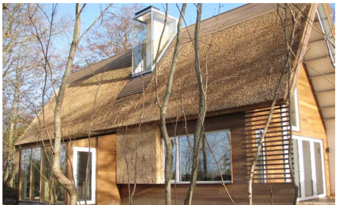
Foto: Det åndbare Hus ved Ringsted. Der er foretaget målinger af fugt og afdampning i huset. De har aldrig vist mere end 13 procent fugt i stråtaget, som dermed på ingen måde er i fare ved høj fugtighed inde fra huset, selvom huset ikke har dampspærre. Inden længe flytter en familie ind i huset. Målingerne vil vise, hvad deres fordampning medfører. Alt tyder på, at huset evner at borttransportere fugten uden at skade byggematerialerne.
