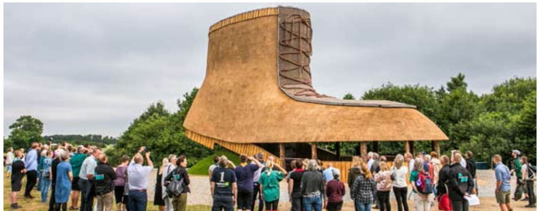
Foto: Det åndbare Hus ved Ringsted. Der er foretaget målinger af fugt og afdampning i huset. De har aldrig vist mere end 13 procent fugt i stråtaget, som dermed på ingen måde er i fare ved høj fugtighed inde fra huset, selvom huset ikke har dampspærre. Inden længe flytter en familie ind i huset. Målingerne vil vise, hvad deres fordampning medfører. Alt tyder på, at huset evner at borttransportere fugten uden at skade byggematerialerne.
