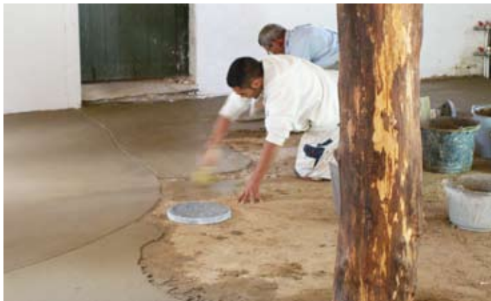
Etablering af lergulv
