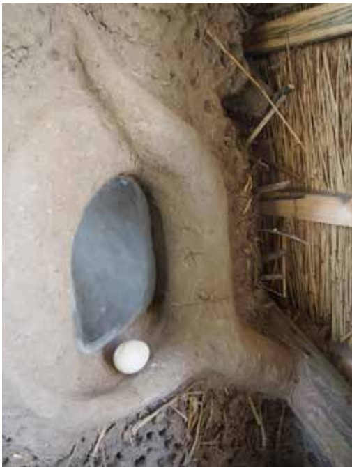
Små detaljer når vi leger. Til højre i billedet ses indersiden af en beskyttende væg af tagrør mod vest.
