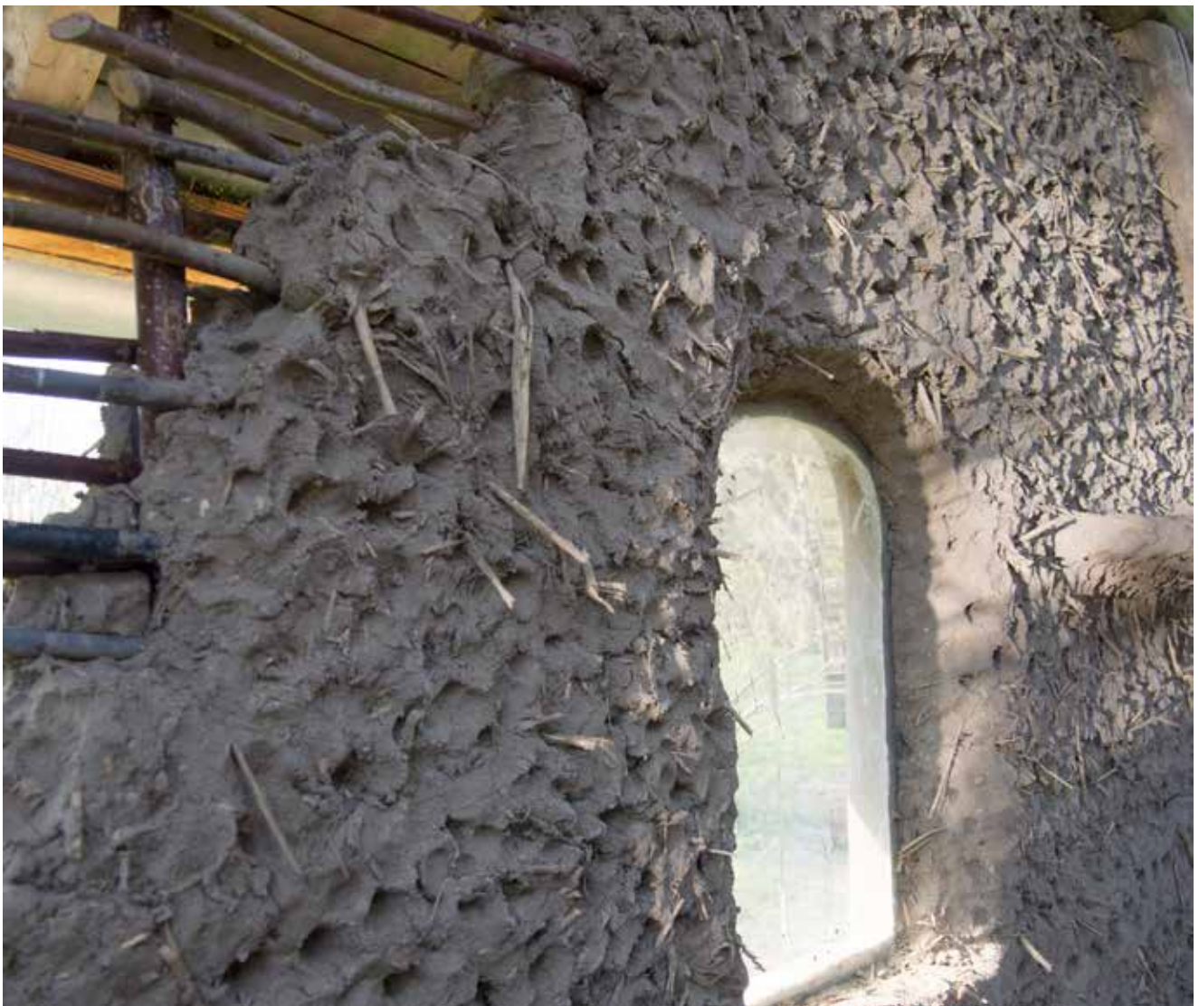
Cobvæg opbygget af lerjord fra udgravning på grunden. Fletværk er hassel og pil.
