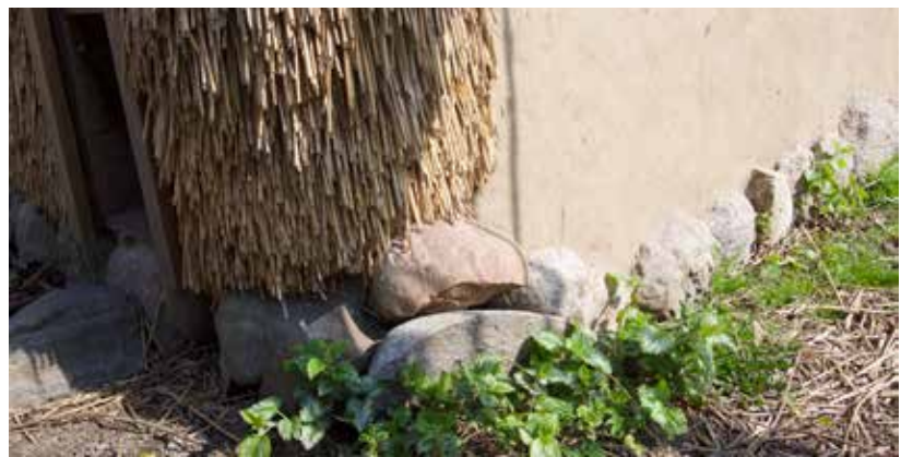
Lodret tækning beskytter cobvæg mod slagregn fra vest.
