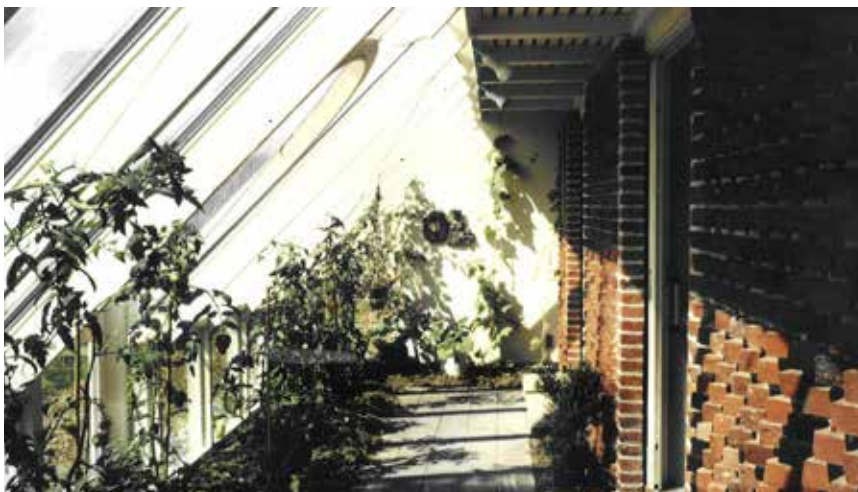
Folkesolhuset – sydvendt passiv solrum – glasside m/solfanger som skygge giver – solfanger leverer til varmtvandsbeholder – overskud af varme går til ribberør i sandlager under et rum i midten af huset. Uopvarmet skurum og bryggers ligger i nord som buffer for varmetab. I passiv solrum er der tungt murstensgulv og mørk murstenvæg med ekstra stor (dobbeltspecifikt) overflade. Projektår: 1986-88
