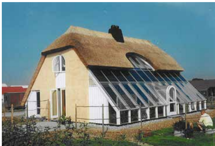
Folkesolhuset – sydvendt passiv solrum – glasside m/solfanger som skygge giver – solfanger leverer til varmtvandsbeholder – overskud af varme går til ribberør i sandlager under et rum i midten af huset. Uopvarmet skurum og bryggers ligger i nord som buffer for varmetab. I passiv solrum er der tungt murstensgulv og mørk murstenvæg med ekstra stor (dobbeltspecifikt) overflade. Projektår: 1986-88
