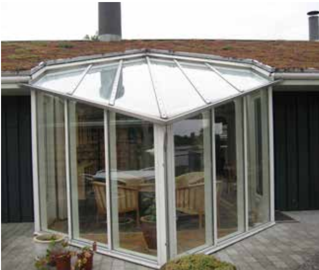
En lille sydvendt glaskarnap, med teglfliser på gulv. En isoleringsgardin kan trækkes for om natten. Huset har indvendigt filtset murværk, udvendigt isolering og listedække af douglasbrædder. Sedumtag. Projektår 1996
