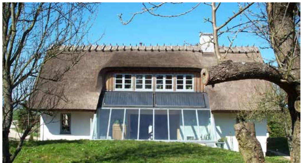
Landhus med stråtag, indvendigt bindingsværk, udvendigt isoleret med puds. Mod syd solrum (delvist nedgravet), over glastaget er der solfanger (skygge giver om sommeren), skydedøre gemt i hulmur er ofte åbne til glæde for inderzonen. Projektår 2004-5
