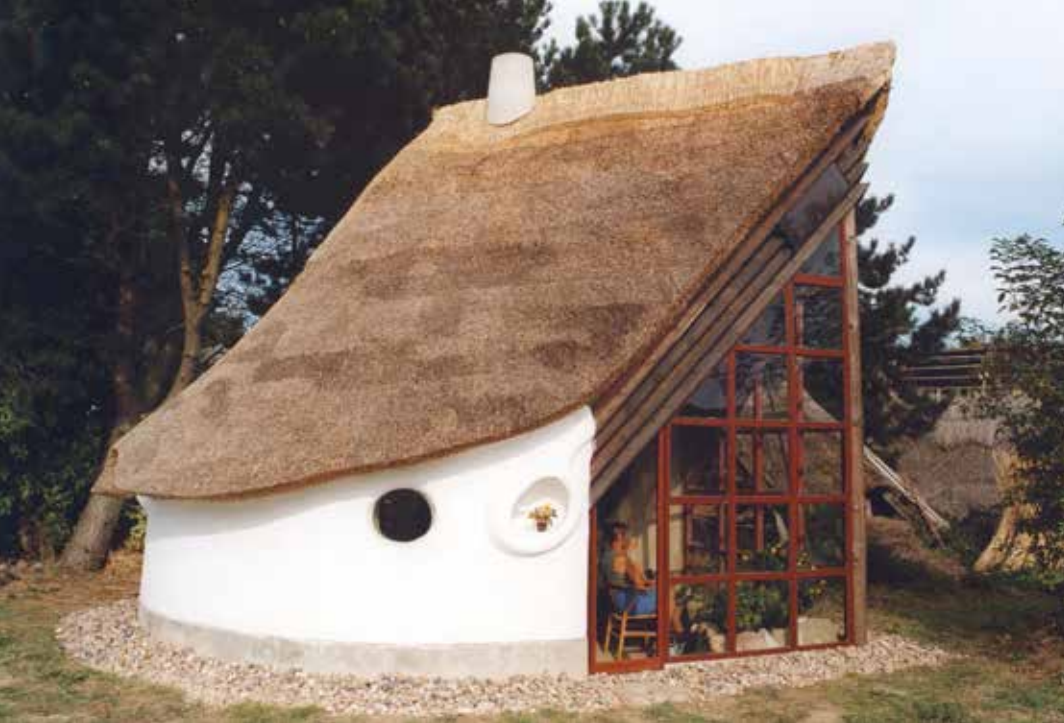
COB-hus med langhalmstag (rug), sydvendt integreret solrum med lergulv og jordbed. Huset har raketovn, er off-grid og er ikke ekstra isoleret - fugtbalancen altid god. Projektår 1996-97
