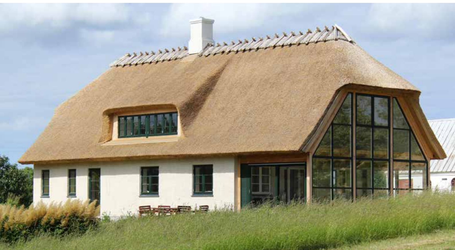
Landhus med strå af dansk dyrket miscanthus (elefantgræs) på taget, med sydvendt solrum i gavl – udnyttet både i stue og tagrum. Indvendigt murstengulve – der er jordvarmeanlæg og masseovn. Huset er med hulmur, som er isoleret med indblæst løst polystyren. Projektår: 2016-18
