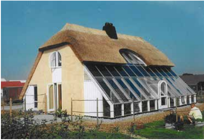
Folketsolhuset – sydvendt passiv solrum – glasside m/solfanger som skygge giver – solfanger leverer til varmtvandsbeholder – overskud af varme går til ribberør i sandlager under et rum i midten af huset. Uopvarmet skurum og bryggers ligger i nord som buffer for varmetab. I passiv solrum er der tungt murstensgulv og mørk murstensvæg med ekstra stor (dobbeltspecifikt) overflade. Projektår: 1986-88
