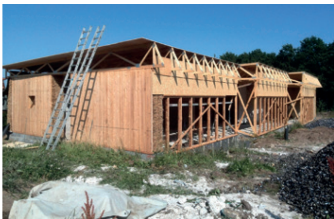
Byggeri af restaurant MOMENT
