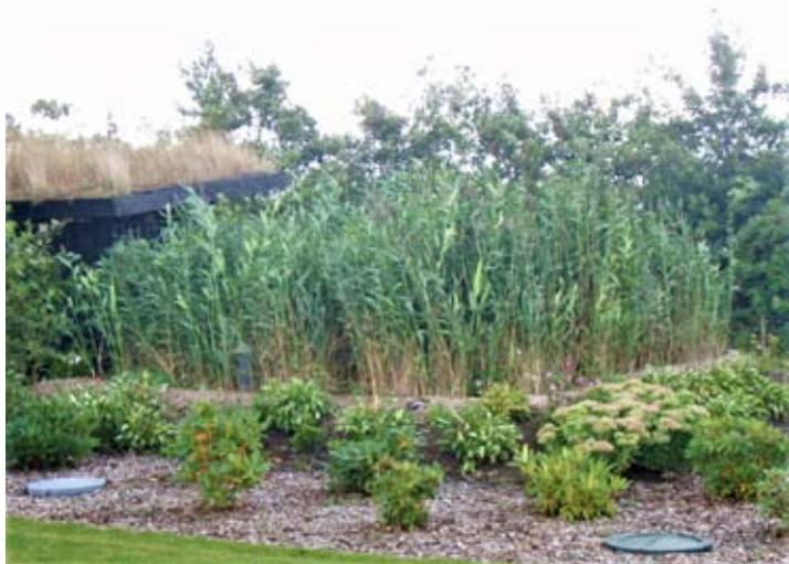
Foto: Tagrør ovenpå det beplantede filteranlæg isolerer anlægget om vinteren. Her anlæg ved Herning.
