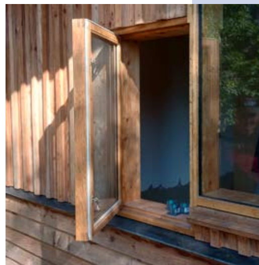
3 fotos: Her ses, at hvor vinduerne ikke går ned til skifersålbænken bruges offerbrædt under vinduet.
