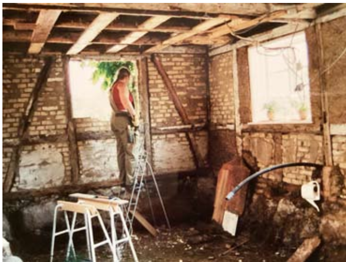
Foto: Afrensning af bindingsværket indvendig. Gulvet er sænket 30-40 cm så sølstenene ses under bindingsværket. Rummet er det kommende køkken.
