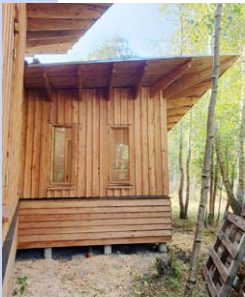
Foto: NB punktfundamenter i beton.
