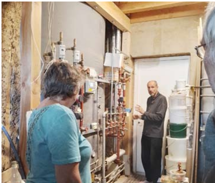
Foto: Bernhard viser akkumulerings tanken og styringsanlægget.
