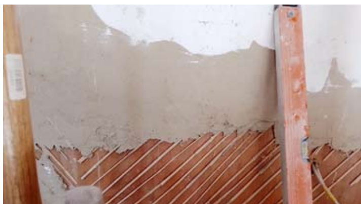
Fotos: Stuen udefra og indefra og udsnit, der viser vægens lerpudsopbygning.
