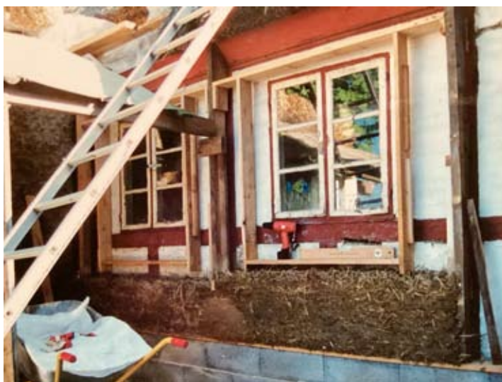
Foto: Ovenpå det nye udvendige fundament er bindingsværket udvendigt isoleret med sammenpresset halm og ler, kaldet letler.
