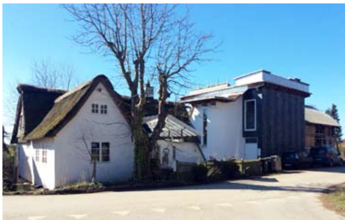
Foto: Bindingsværkshuset til venstre og tilbygning til højre.
