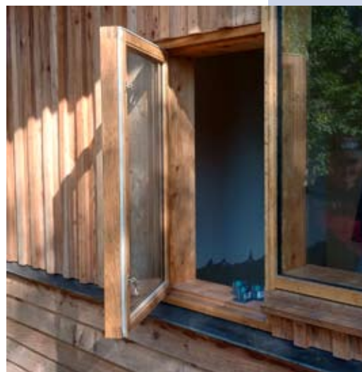
3 fotos: Her ses, at hvor vinduerne ikke går ned til skifersålbænken bruges offerbrædt under vinduet.
