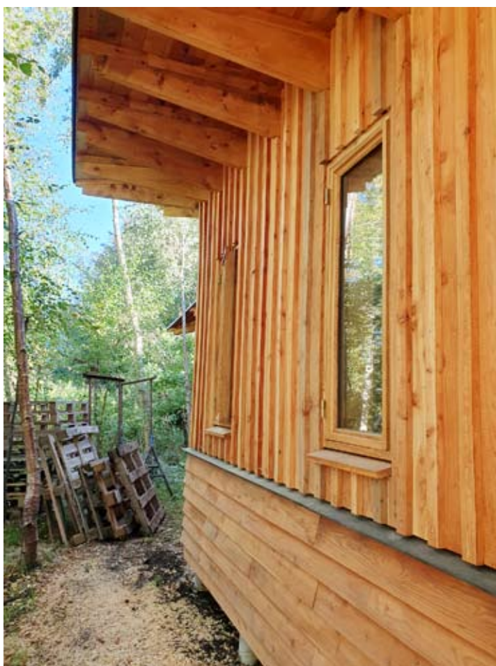
3 fotos: Her ses, at hvor vinduerne ikke går ned til skifersålbænken bruges offerbrædt under vinduet.
