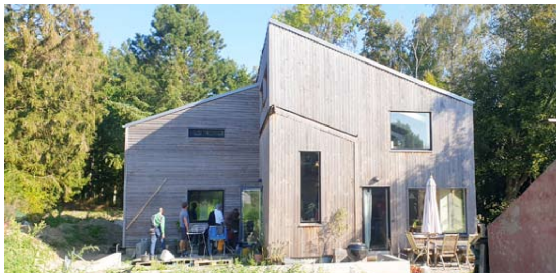
Foto: Der er gjort forberedelser til orangeri i facade og fundament i forgrunden af huset.
