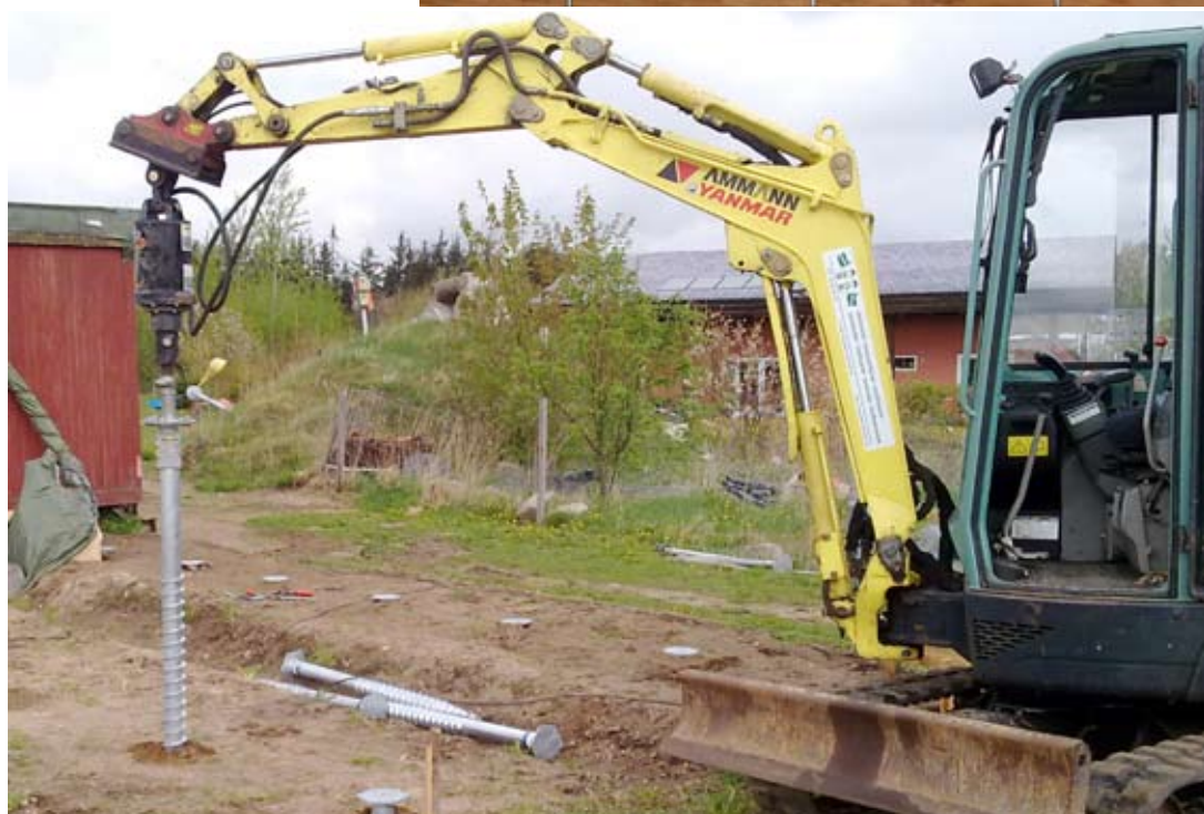
Fotos: På snittet til højre ses at huset hviler på fundaments-skruer. På billedet herunder bores fundamentsskrue i jorden. Herover ses fundaments-trærammen med afdækning mod jord.
