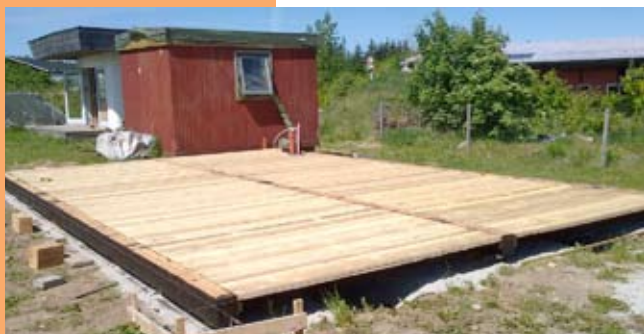
Fotos: På snittet til højre ses at huset hviler på fundaments-skruer. På billedet herunder bores fundamentsskrue i jorden. Herover ses fundaments-trærammen med afdækning mod jord.
