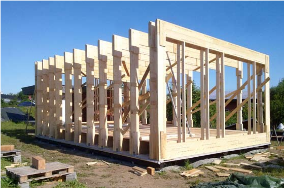
Foto: Rammekonstruktionen monteret på fundaments-trærammen.
