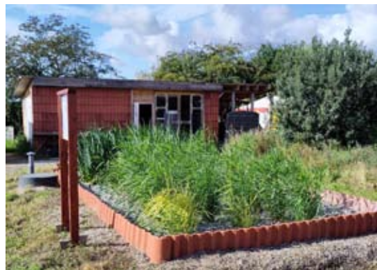
Fotos: Herover ses Tiny Varighedens spildevandsanlæg med beplantning set fra Fælleshuset. På billedet herunder ses anlægget med beluftning på et tidspunkt, hvor der ikke er kommet så mange planter endnu. På et skilt ved anlægget informerer Kilian Water om principperne for rensningsprocessen.
